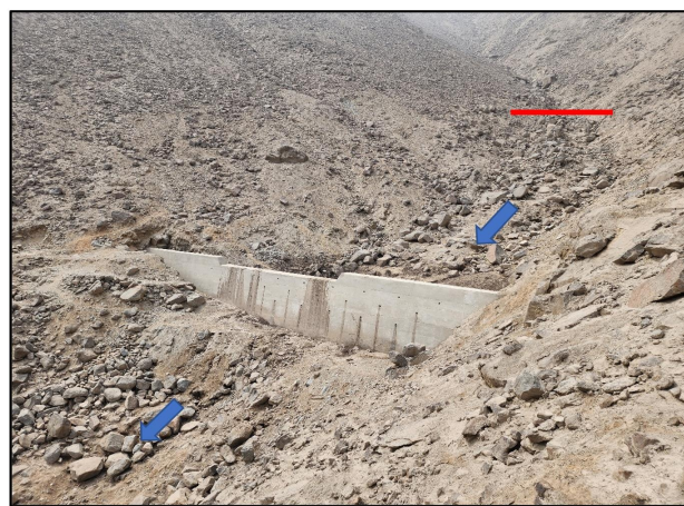
Imagen N° 02: Cauce de la quebrada, vista hacia aguas arriba, se aprecia dique existente y eje de dique proyectado.
